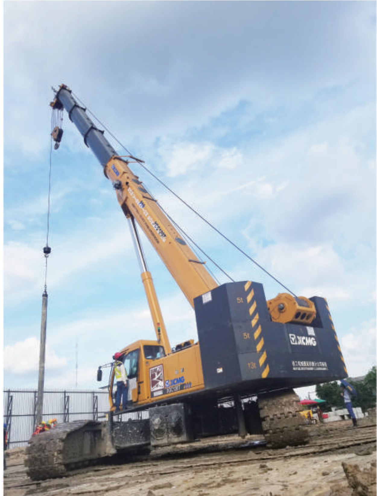
■ XGC120T泰国曼谷基础建设项目施工
