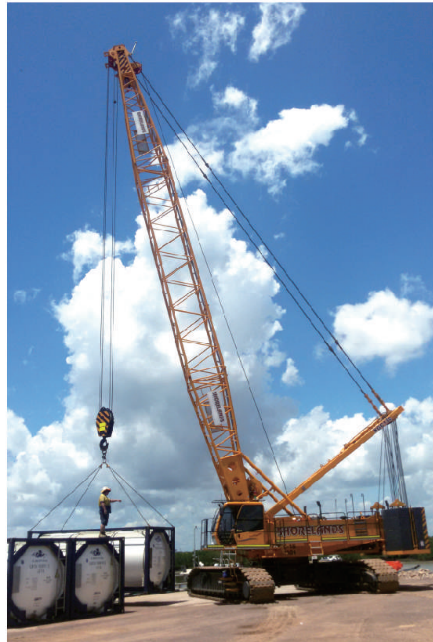
■ XGC130澳大利亚施工
