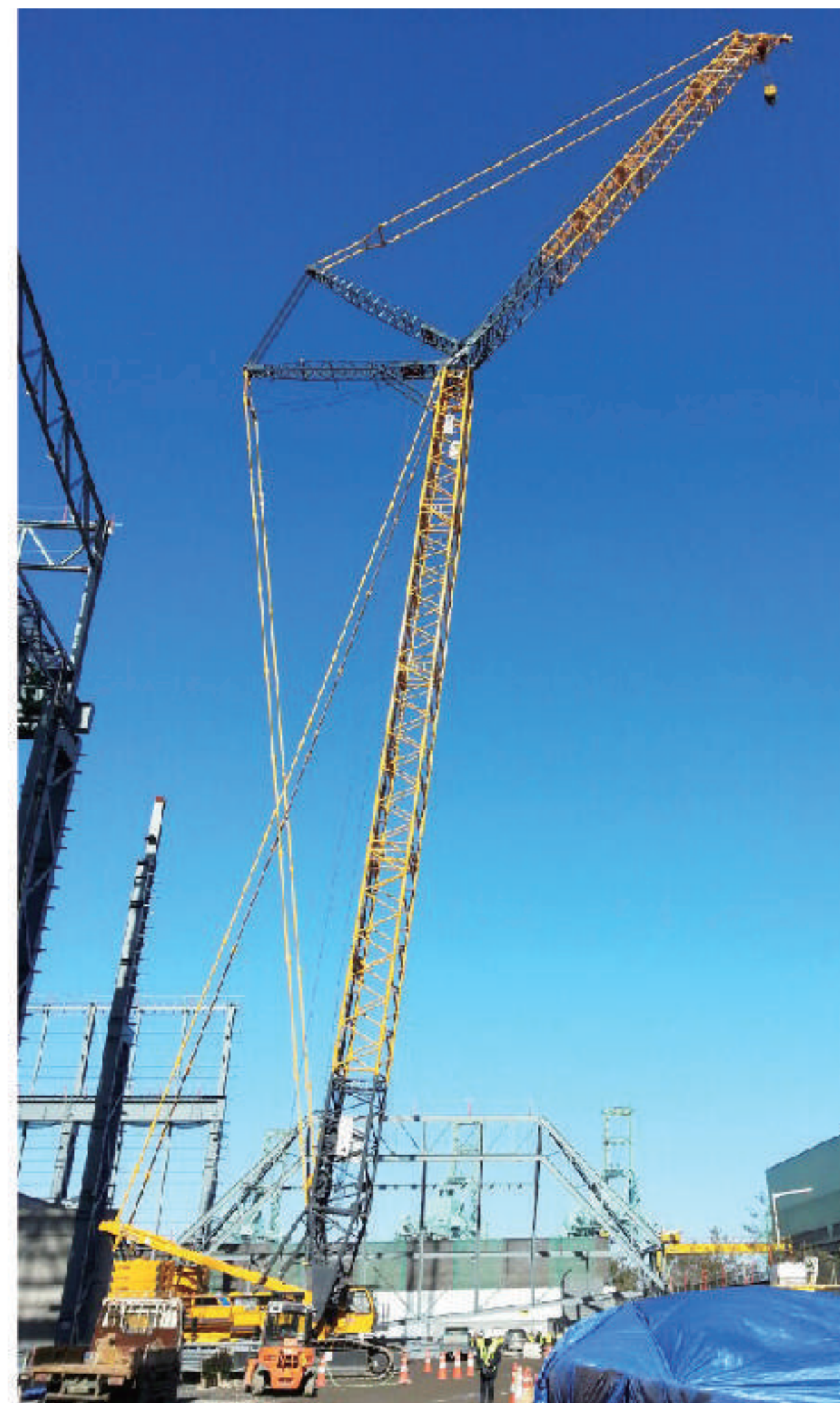
■ XGC400韩国施工
