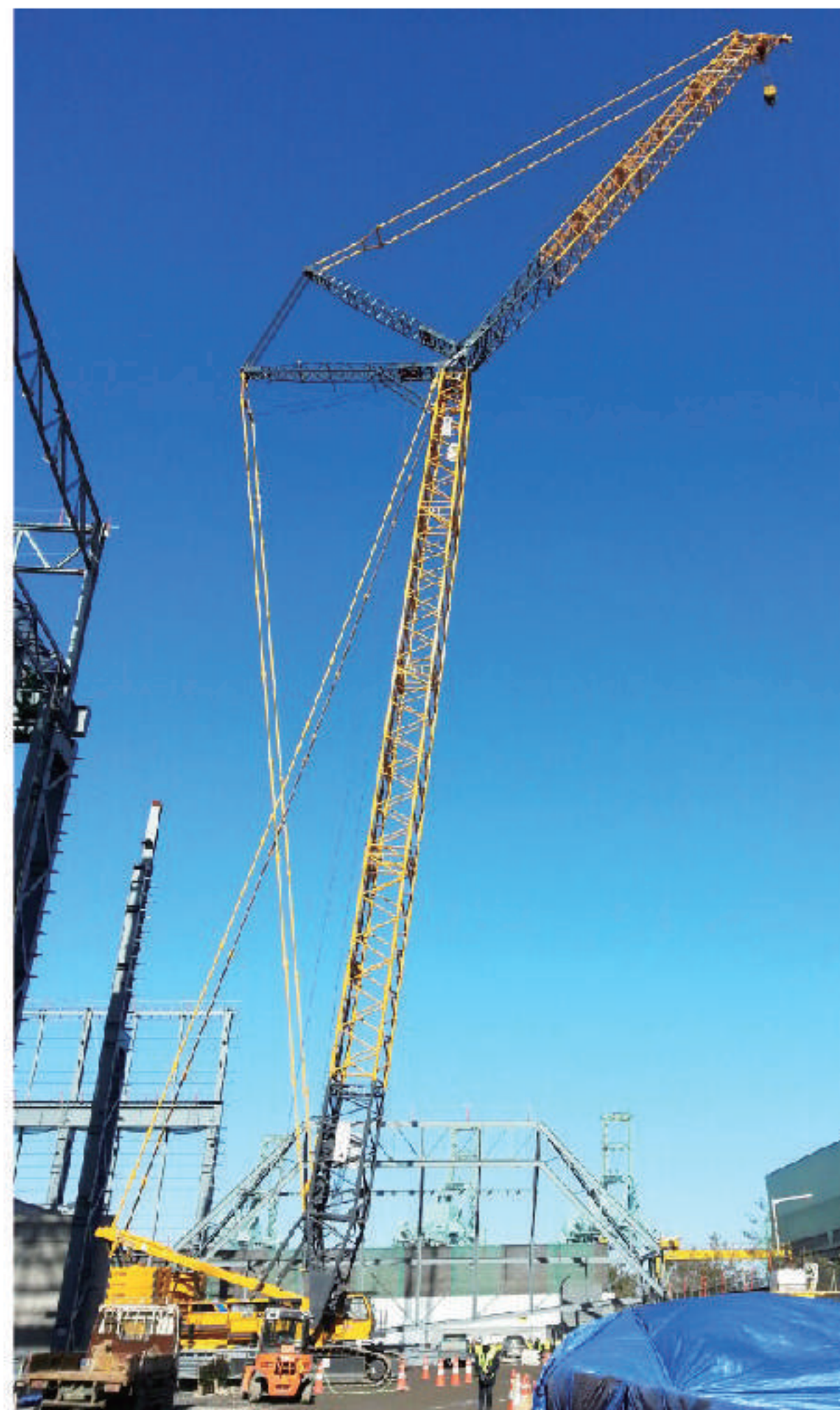
■ XGC400韩国施工
