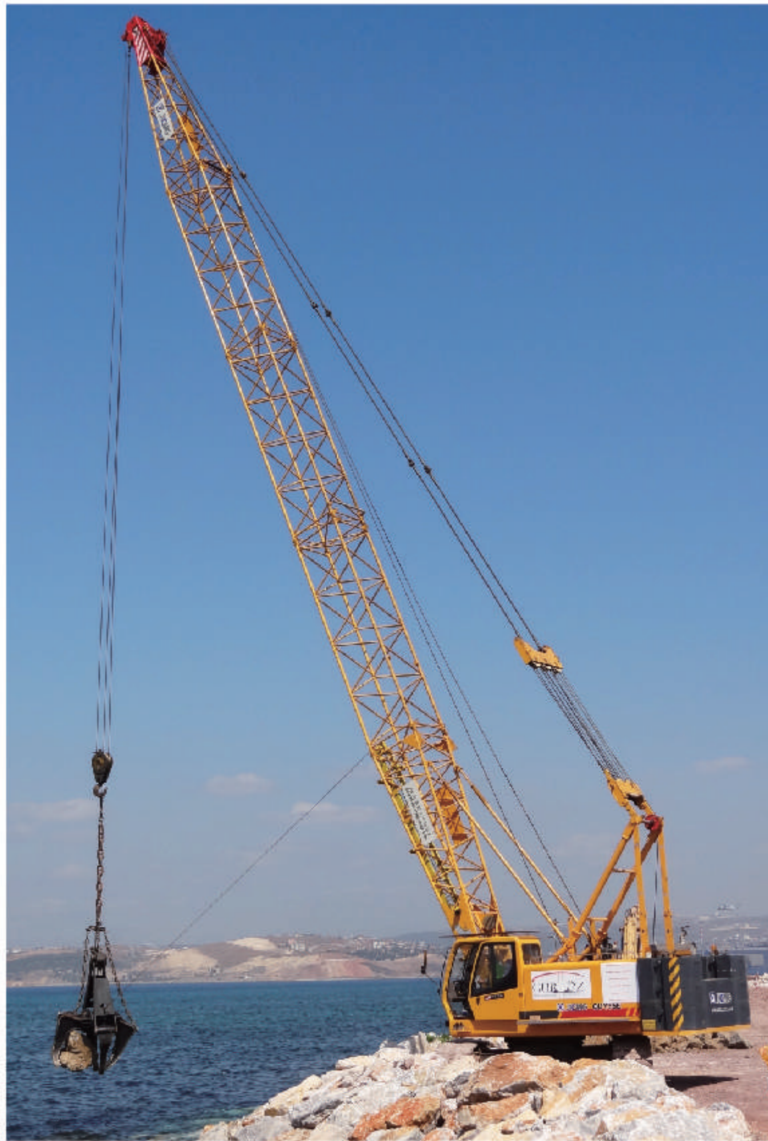
■ 55吨履带起重机土耳其施工
