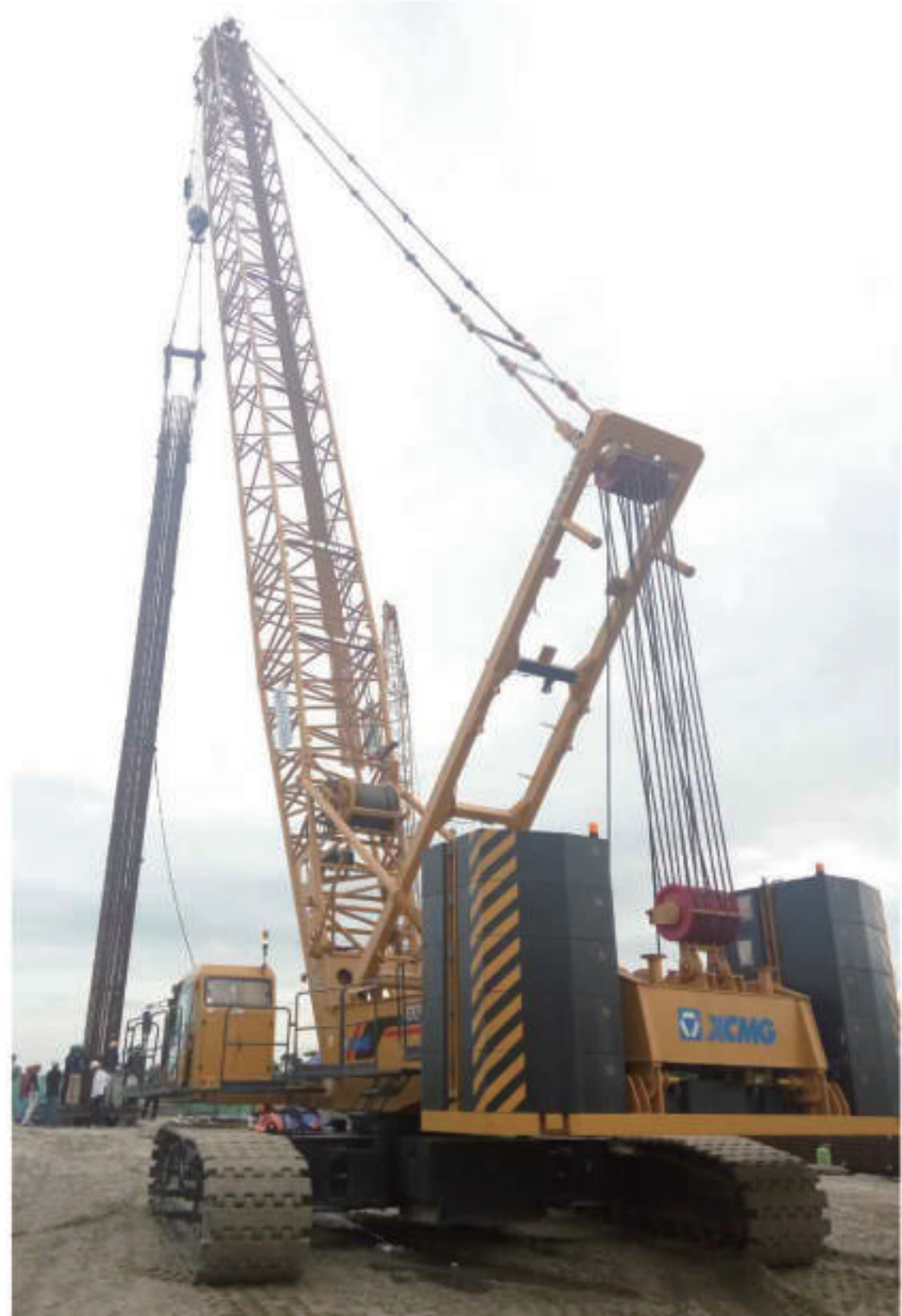
■ 徐工XGC180孟加拉帕德玛大桥项目施工
