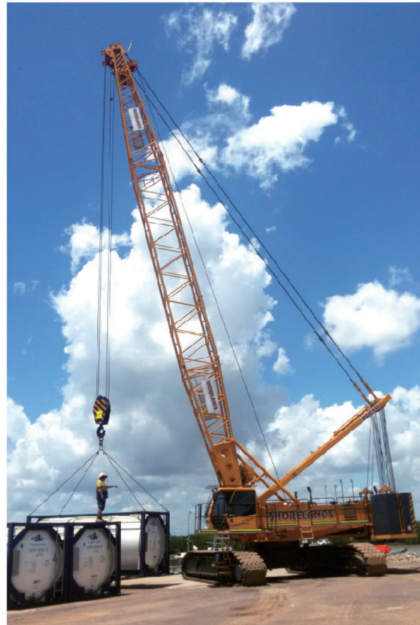
■ XGC130澳大利亚施工
