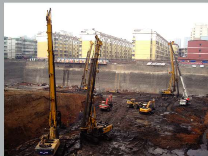
山西徐工旋挖钻机群施工
