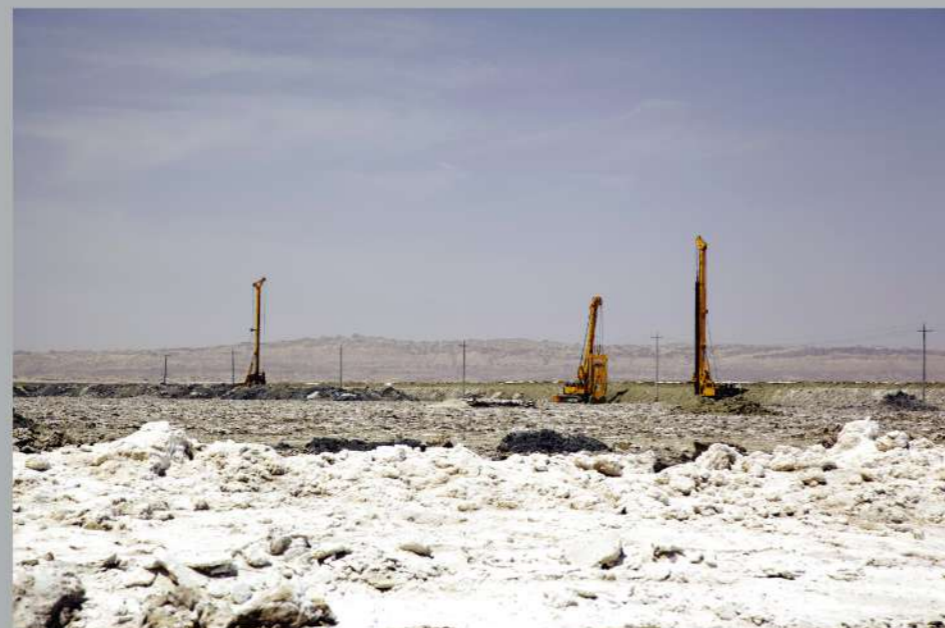
徐工旋挖钻连续墙新疆施工
