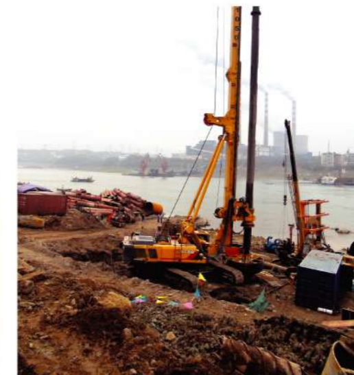
SRS1050重庆施工
