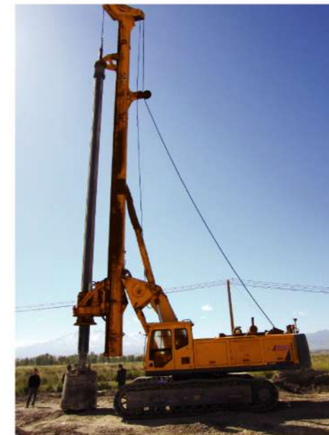
兰新铁路施工
