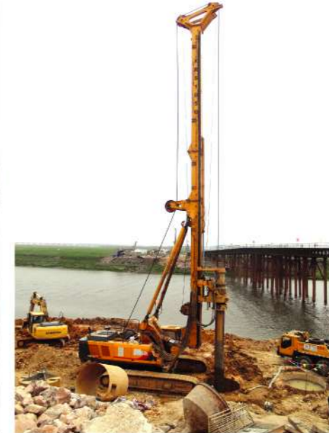
XRS1050武汉施工
