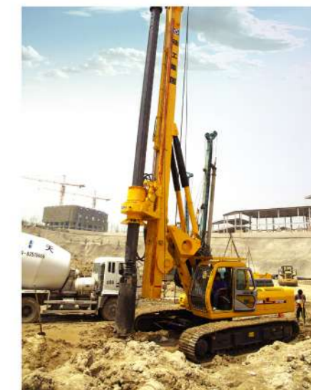
西安浐灞新区施工
