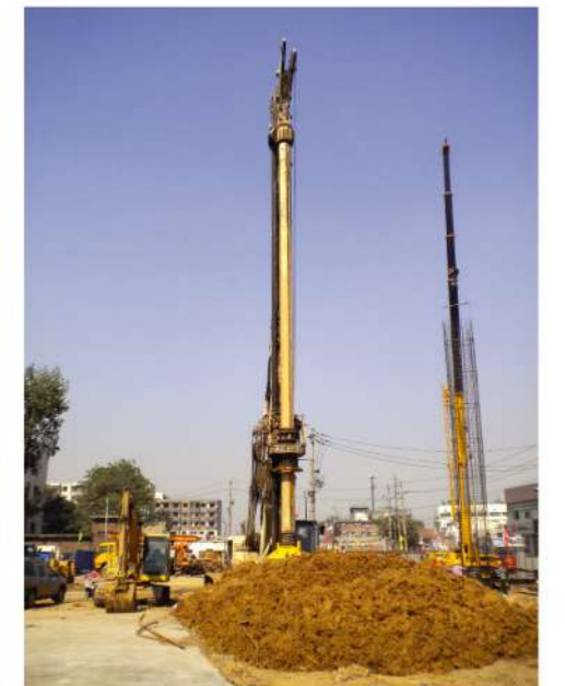
郑州高架桥施工现场
