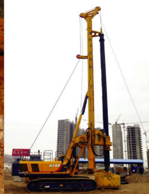
XR360甘肃施工
