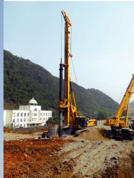
XR280D贵阳施工
