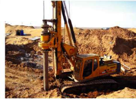
XR150D内蒙施工
