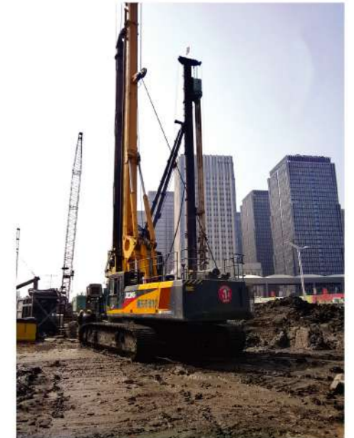
XR280D南京市政施工
