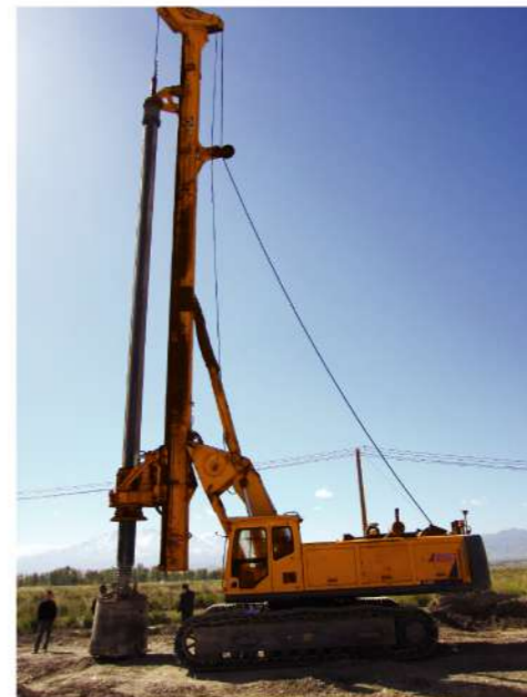
兰新铁路施工
