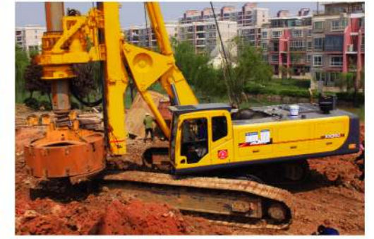
合肥绕城高铁施工
