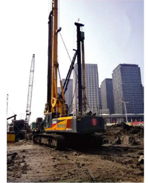
XR280D南京市政施工
