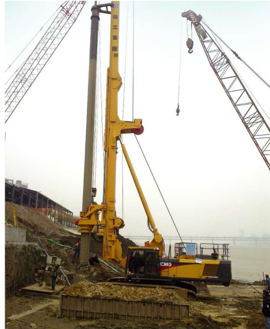
XRS1050在武汉施工
