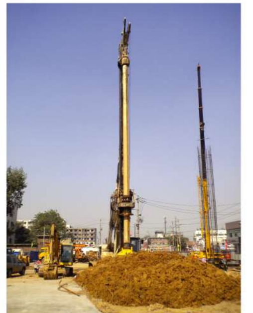
郑州高架桥施工现场
