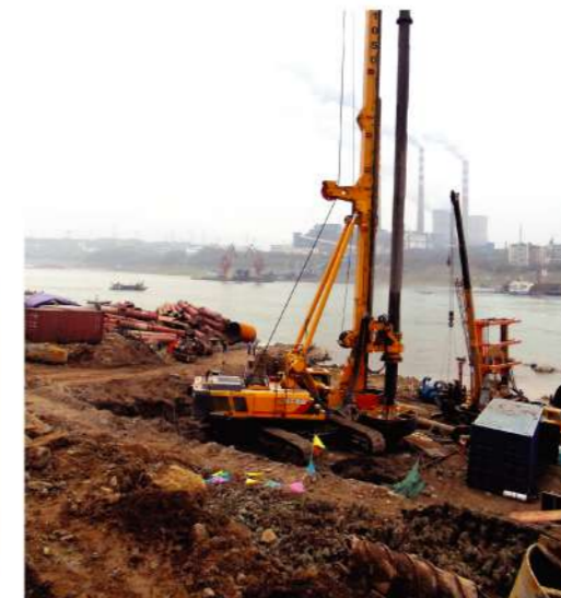
SRS1050重庆施工
